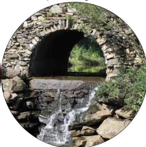
stone bridge Puente de rocas
